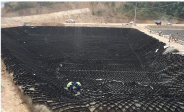
Figura 25. Abertura das Geocélulas.
