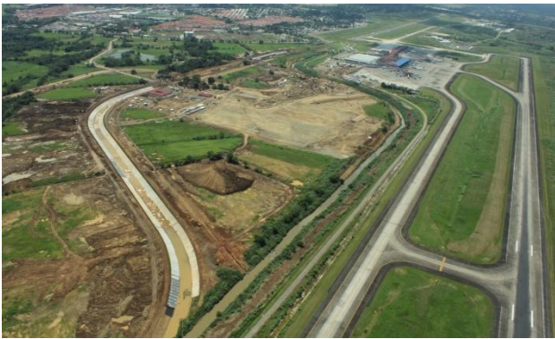
Figura 17. Vista Aérea da Construção do Novo Canal no Lado Esquerdo da Foto.
