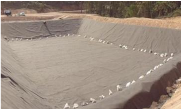
Figura 24. Instalação do Geotêxtil Nãotecido de Proteção.
