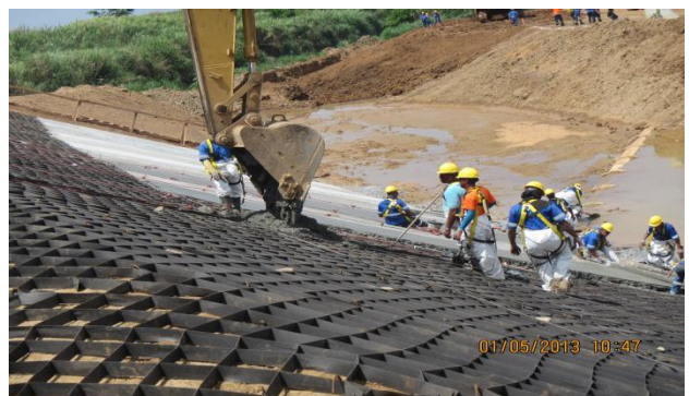
Figura 19. Concretagem das Geocélulas nos Taludes.
