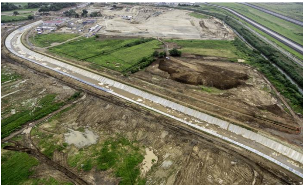
Figura 22. Vista Aérea da Conclusão do Canal.
