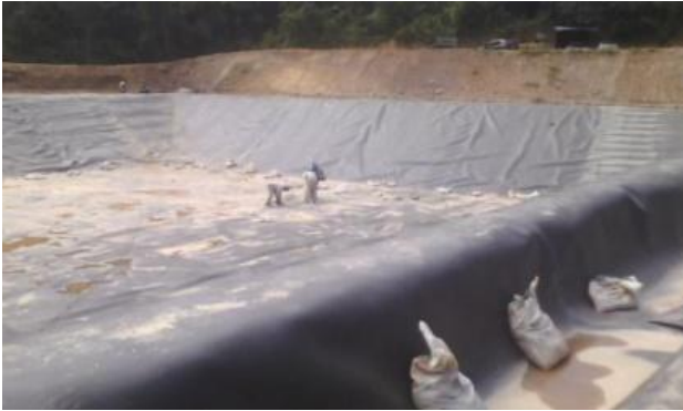
Figura 23. Instalação de geomembrana de PEAD em uma das Lagoas de Chorume.
