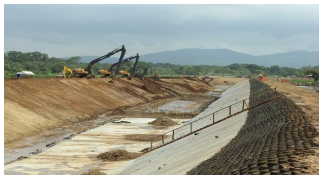
Figura 18. Processo de Regularização do Canal.
