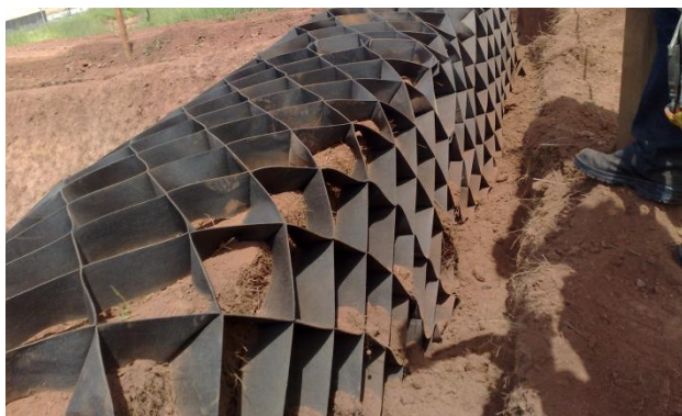
Figura 5. Sistema de Ancoragem das Geocélulas.
