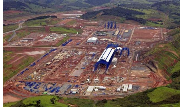
Figura 2. Visão Geral da Construção da Fábrica.
