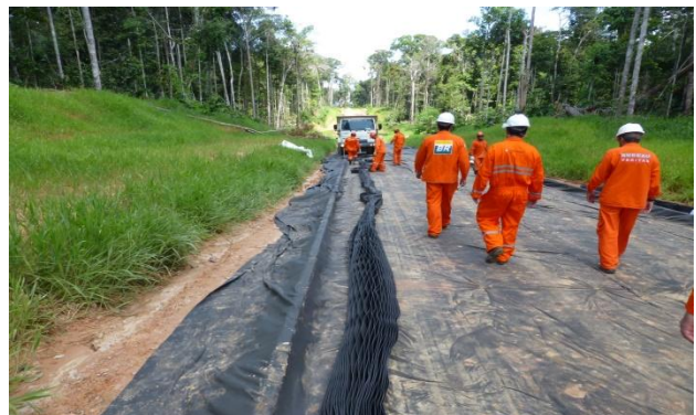
Figura 11. Aplicação do Geotêxtil Não-tecido.
