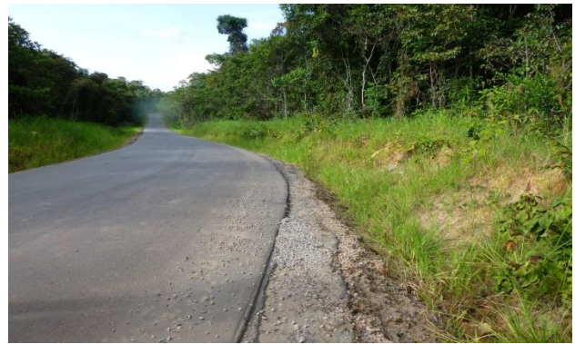
Figura 16. Acabamento Final com Pavimento Asfáltico.
