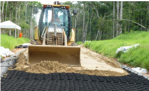
Figura 14. Preenchimento das Células com Solo Arenoso.
