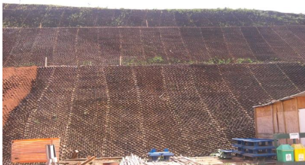
Figura 6. Vista dos Taludes com as Geocélulas.
