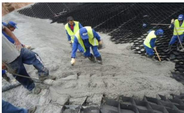
Figura 26. Concretagem das Geocélulas nos Taludes.
