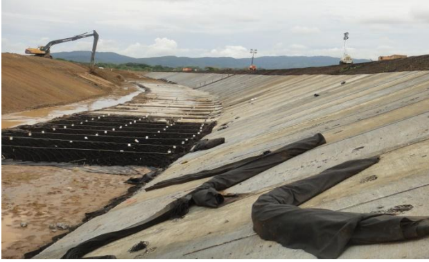
Figura 20. Instalação das Geocélulas na Base do Canal.
