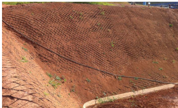
Figura 7. Preenchimento das Geocélulas com Solo e Aplicação da Hidrosemeadura.
