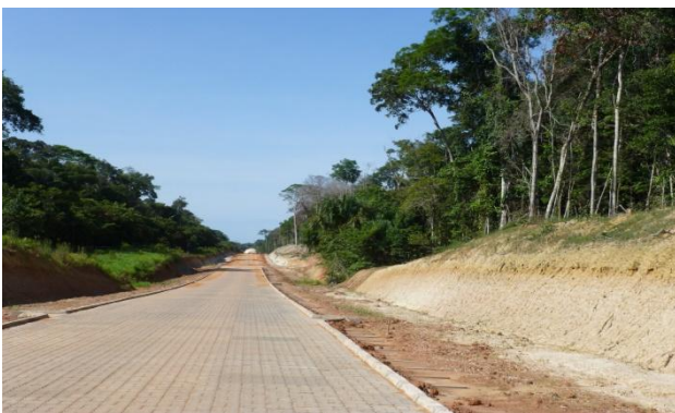
Figura 15. Acabamento Final com Blocos Intertravados.
