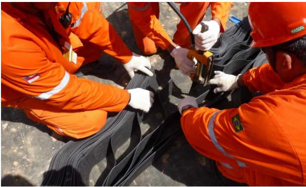
Figura 12. Sistema de grampeamento das geocélulas.
