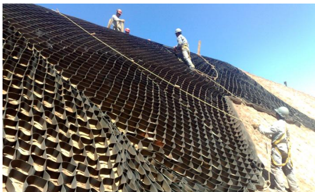
Figura 4. Início da Instalação das Geocélulas.
