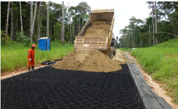
Figura 13. Preenchimento das Células com Solo Arenoso.
