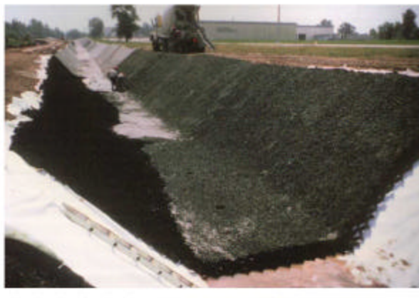
Figura 21 – Canal protegido por geocélulas preenchidas por concreto (Fonte: Presto)
