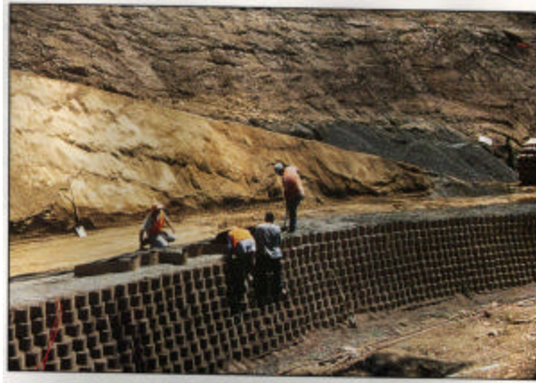
Figura 20 – Talude reforçado por geocélulas (Fonte: Presto)
