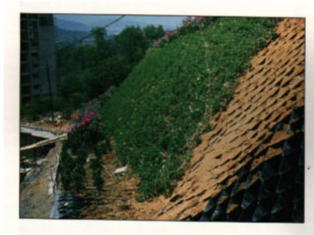
Figura 19 – Talude vegetado em geocélulas (Fonte: Presto)
