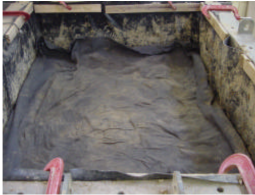
Figura 51 – Geotêxtil de separação
