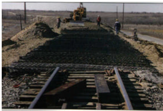
Figura 22 – Leito ferroviário reforçado com geocélulas (Fonte: Presto)
