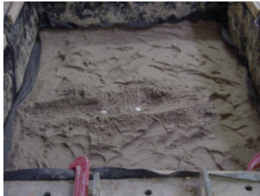
Figura 52 – Camada de areia de regularização
